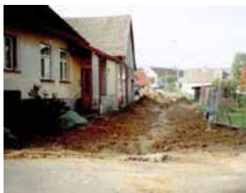
Rekonstrukce cesty u křížku v roce 2005
