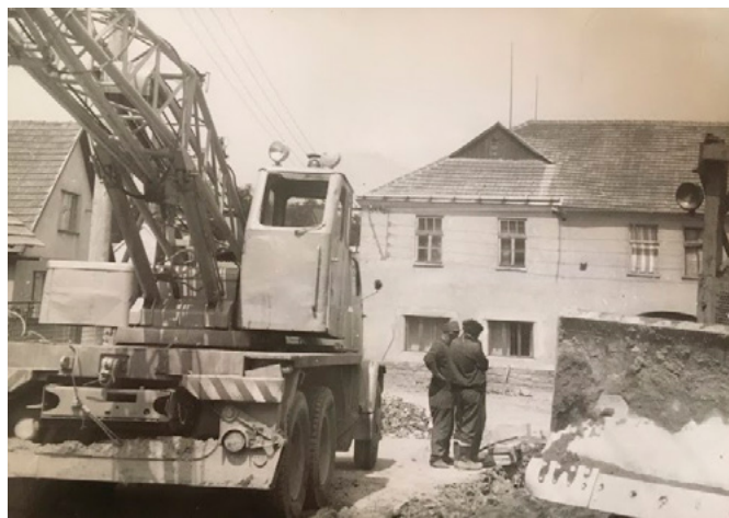
Technika v provozu při budování kanalizace.
