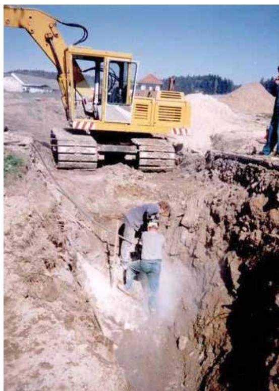
Stavba kořenové čističky odpadních vod
