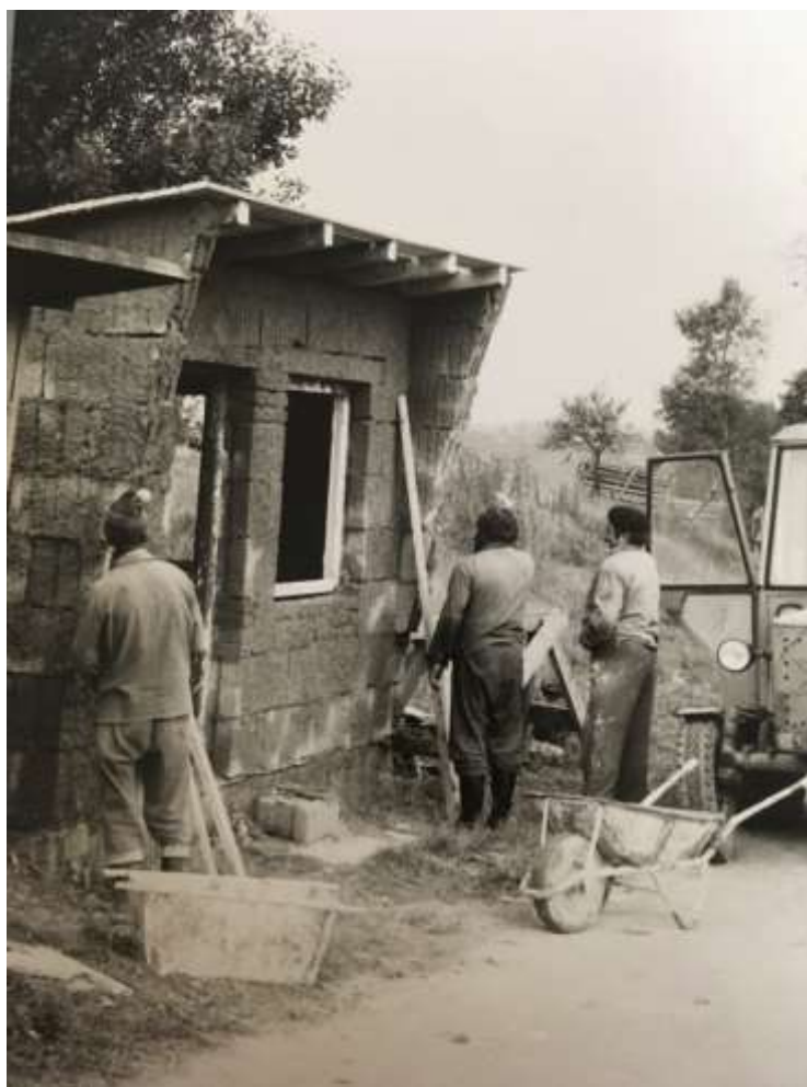
Stavba čekárny na rozcestí
